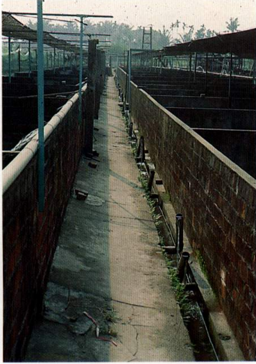
(圖3) 牛蛙池L型排水管，可調節水位。
